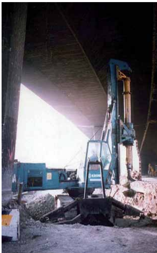
➔ Fotografías 1 y 2.- Equipos de pilotes. Comparación entre equipo convencional y equipo para gálibos reducidos.
