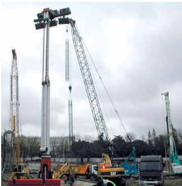
➔ Fotografía 1.- Izado de armaduras para su colocación dentro de la perforación.
