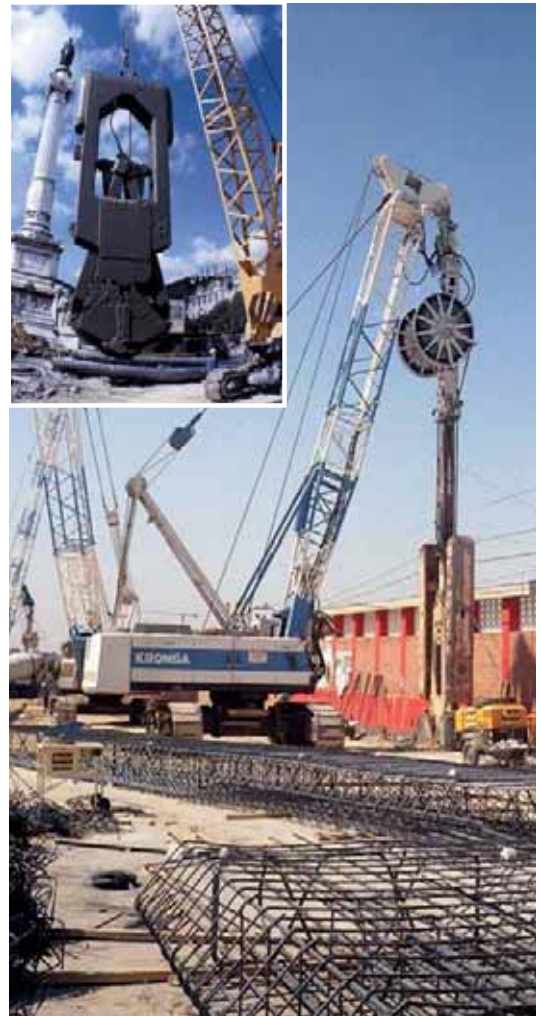
➔ Fotografía 3.- Equipos con cucharas para la excavación de muros-pantalla.
