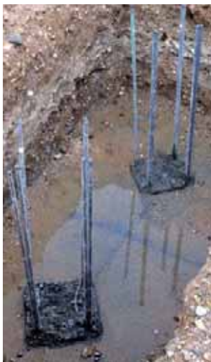
➔ Fotografía 6 y 7.- Conexión con encepado.
