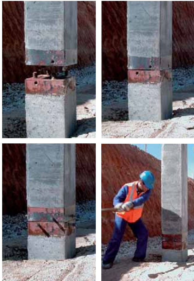
Fotografía 3.- Junta de pilote prefabricado.
