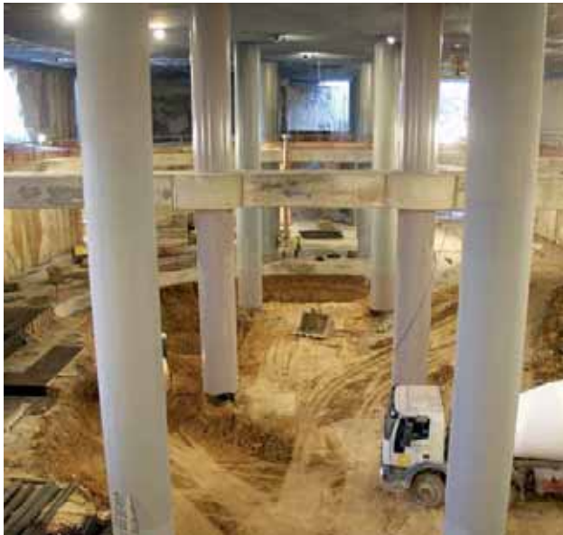
⇒ Fotografía 13.- Estación con estampidores y pilas-pilote.
