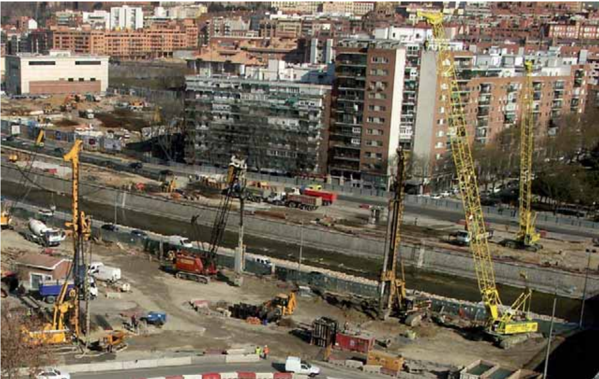
➤ Fotografía 21.- Vista general de la ejecución de pantallas en el río Manzanares, donde puede apreciarse la concentración de equipos trabajando.
