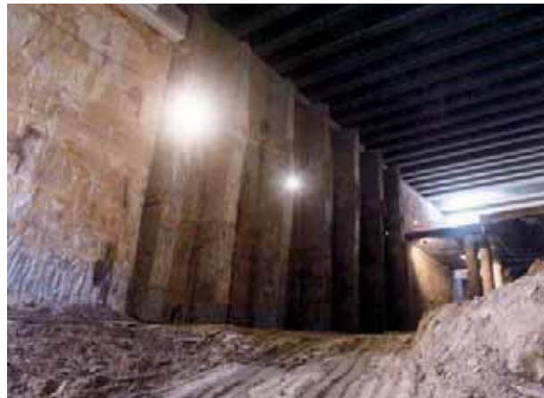
Figura 5.- Ejemplo de un procedimiento de ejecución ascendente-descendente de una estación de metro.
