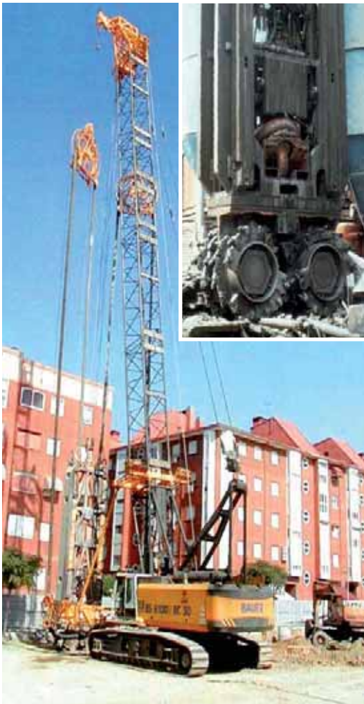
➡ Fotografía 4.- Equipos con hidrofresa para la excavación de muros-pantalla.
