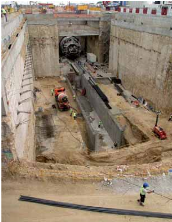
⇒ Fotografías 11 y 12.- Arriostramientos con anclajes y celosías.
