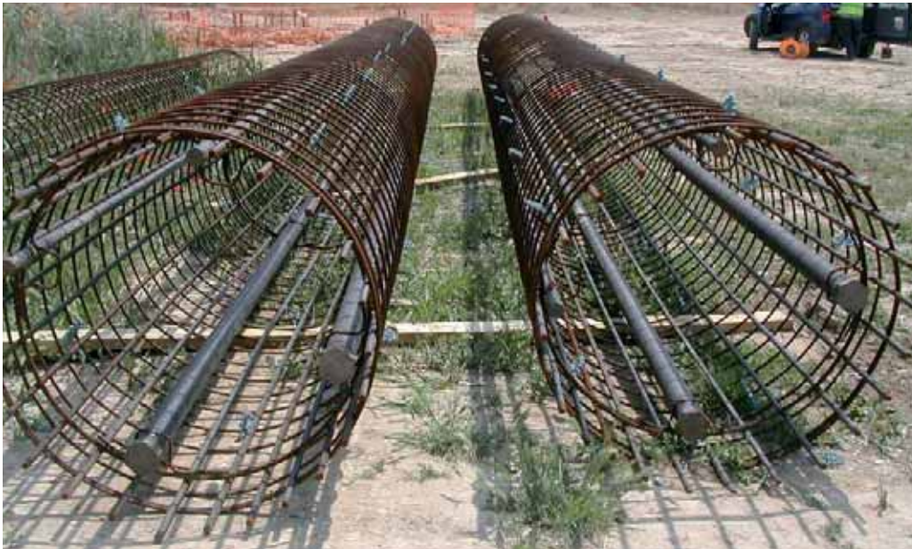
Fotografía 2.- Tubos de auscultación solidarios de las armaduras.
