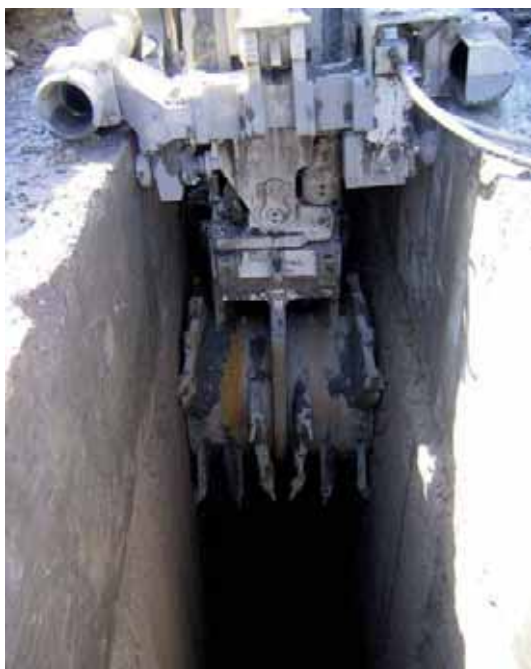
➔ Fotografía 2.- Perforación con fresa.
