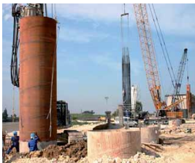
➡ Fotografía 1.- Colocación de la armadura en un pilote de extracción.
