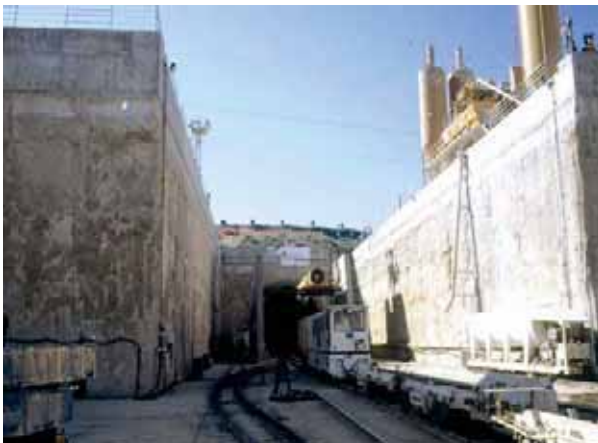
Fotografías 9 y 10.- Voladizos con pantallas y pilotes.
