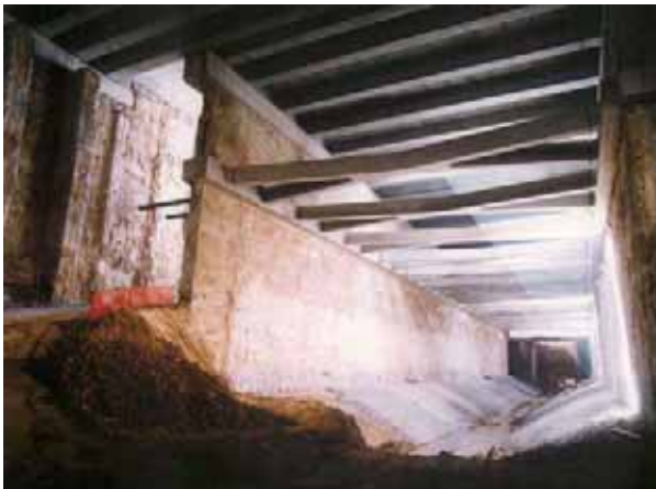
Fotografías 7 y 8.- Arriostramientos intermedios con vigas y contrafuertes.
