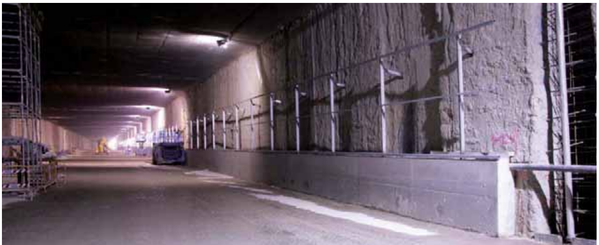
➔ Fotografías 18, 19 y 20. - Sección de túnel en el río Manzanares durante la ejecución y una vez finalizado.
