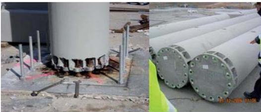
⇒ **Figura 7.-** Detalle del sistema de anclaje de los pilares prefabricados en la planta baja.
