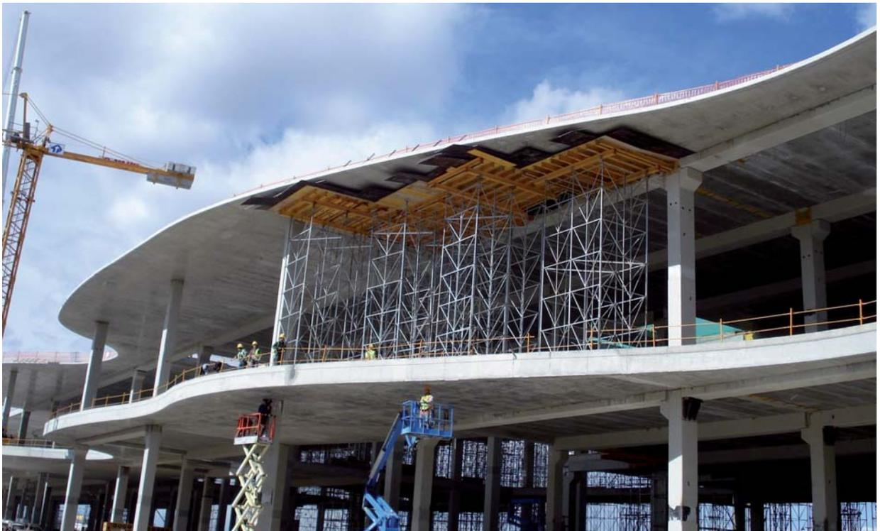
Figura 2.- Detalle de contraste entre estructura prefabricada y ejecutada *in situ* (Edificio Ronda).
