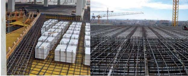
⇒ **Figura 11.-** Detalle del ferrallado de losas ejecutadas *in situ*.
