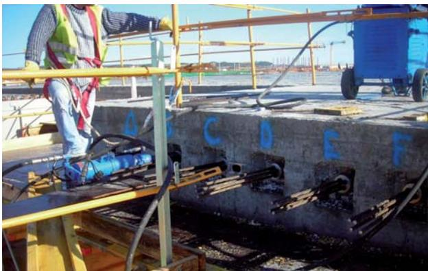
⇒ **Figura 13.-** Detalle de tesado de los cable de pretensado.
