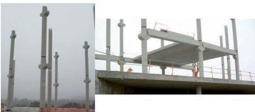
⇒ **Figura 8.-** Detalle del apoyo de vigas prefabricadas sobre pilares prefabricados.
