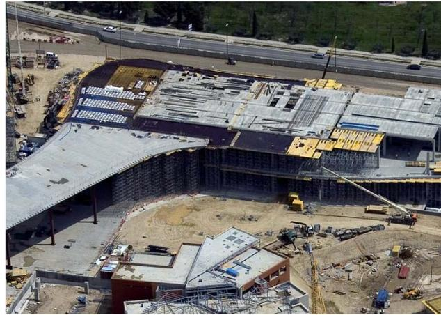
Figura 3.- Vista del edificio de Ranillas mostrando la zona central prefabricada y el perímetro exterior de hormigón *in situ*.
