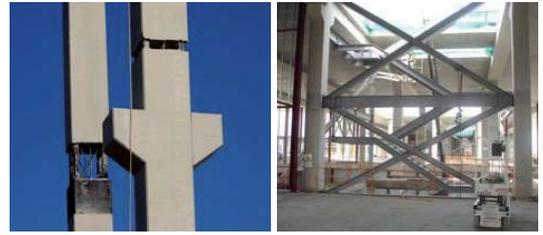
Figura 5.-Detalle de ventana en pilares prefabricados y castillete de rigidización.
