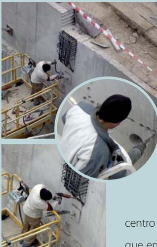
El muro se ejecuta de forma continua sin modificaciones del encofrado para prevenir la existencia de las ménsulas indicadas, que se ejecutan *a posteriori*. Como puede observarse, van fuertemente armadas, lo que requiere la realización de numerosos taladros, muy próximos entre sí, que seguramente producen un plano de corte en el hormigón, lo cual no parece que inquiete a los responsables debido al conocido principio del papel higiénico “nunca se rompe por donde están los agujeritos”.
