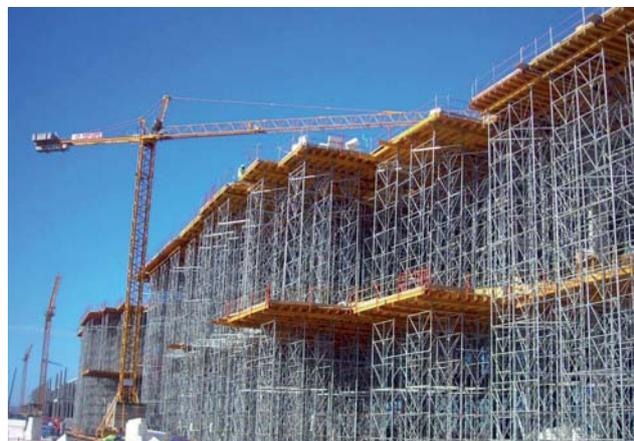
⇒ **Figura 10.-** Detalle del montaje de cimbras para la ejecución de contornos curvilíneos.
