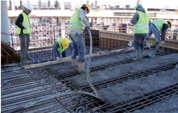
⇒ **Figura 12.-** Detalle del hormigonado de losas ejecutadas *in situ*.
