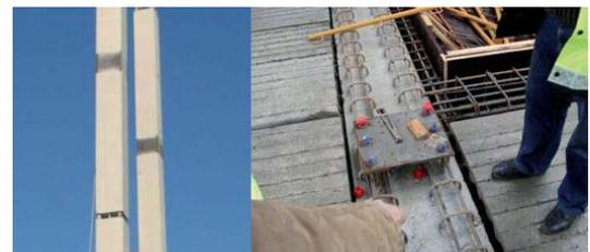
⇒ **Figura 18.-** Detalles de collarín en pilar y placa de anclaje en viga para la fase post-Expo.
