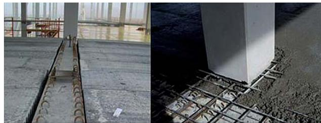
⇒ **Figura 9.-** Apoyo de placas en vigas prefabricadas y detalle de hormigonado de ventanas de pilares prefabricados.
