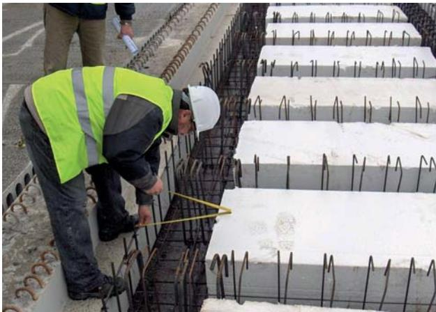
⇒ **Figura 16.-** Detalle de continuidad entre placas alveolares y losa *in situ* en los voladizos.
