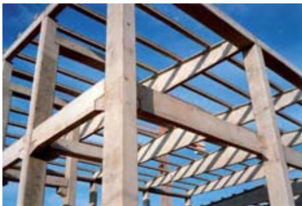
➡ Estructura para depuradora.
