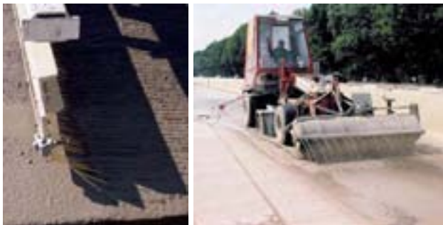
⇒ Figura 4.- Peine para la ejecución del ranurado longitudinal y denudado químico para obtener un acabado con árido visto.
