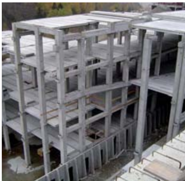
Figura 4. - Estructura totalmente prefabricada con losas alveolares empleadas en los forjados.
