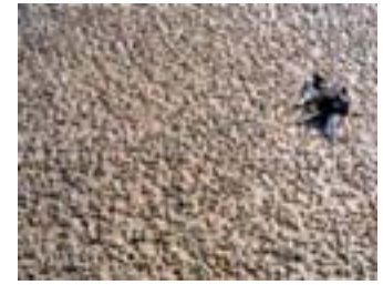
⇒ Figura 5.- Textura de árido visto.
