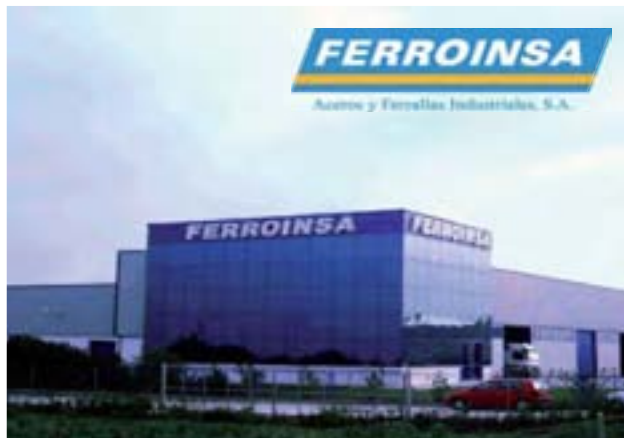
➡ Oficinas de Ferroinsa.
