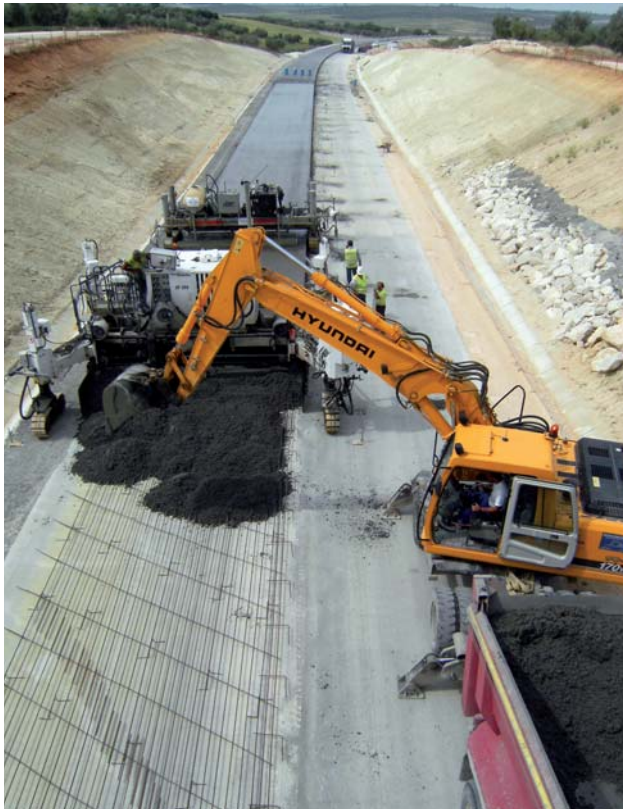
⇒ Figura 8. -Vertido lateral del hormigón ante la extendedora (Cortesía de IECA sur).
