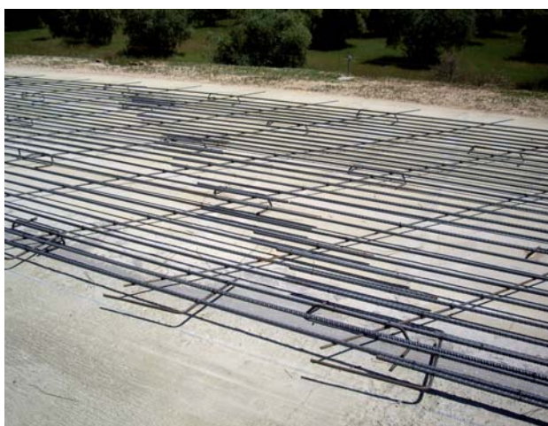
⇒ Figura 6.- Detalle del atado en los solapes, disposición de calzos, armadura transversal y barras de atado.
