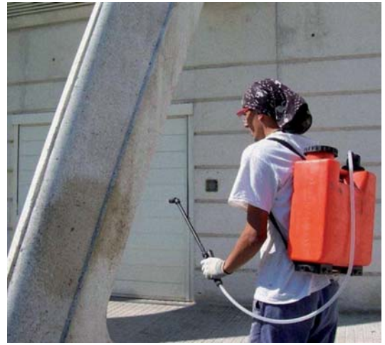
Figura 11.- Aplicación de inhibidores MCI sobre la superficie del hormigón.
