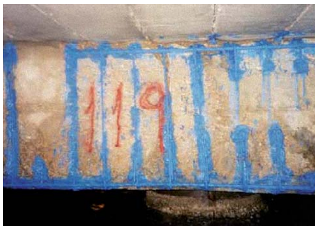
Figura 12.- Aplicación de lechada pasivante sobre el acero desnudo.
