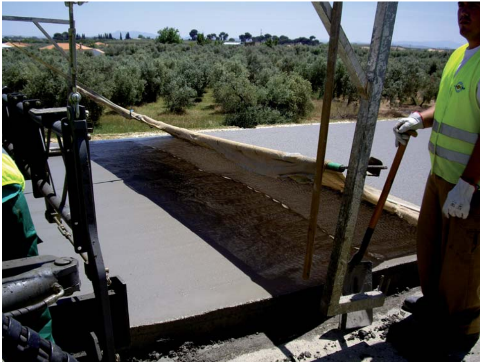
⇒ Figura 9. - Arpillera para proporcionar la textura superficial.
