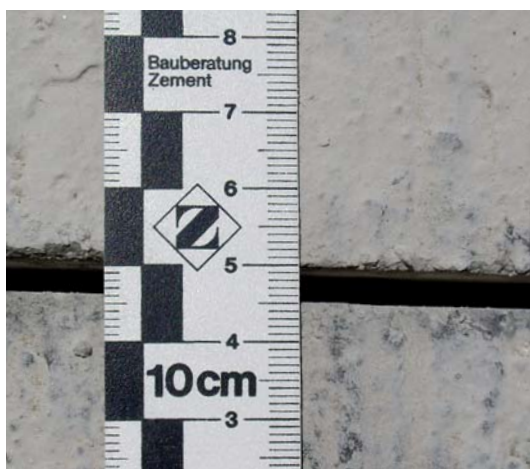
Figura 10.- Detalle del cajeadado de las juntas.
