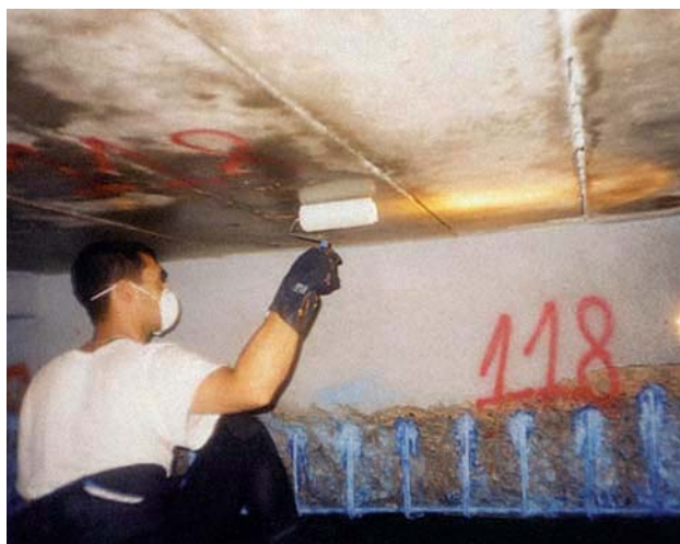
Figura 13.- Aplicación de inhibidores MCI en superficies próximas al área de reparación.
