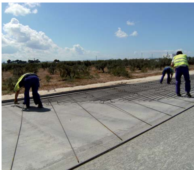
⇒ Figura 5.- Colocación manual de la armadura. Esviaje de solapes y barras transversales (cortesía de IECA sur).
