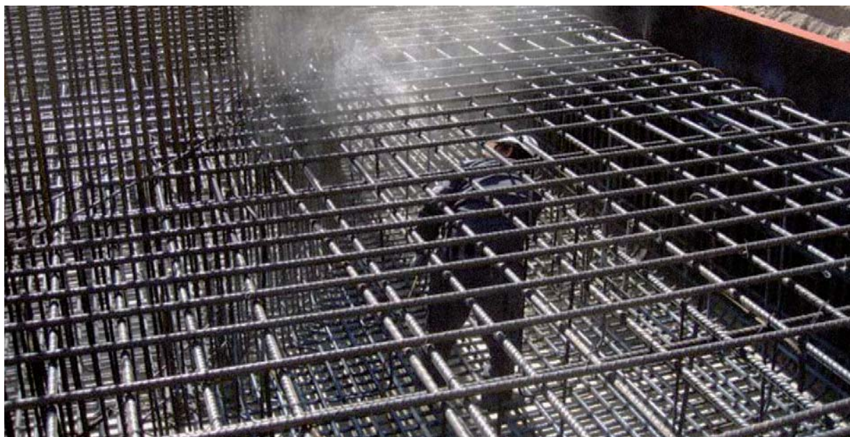
Figura 8.-Detalle de la aplicación mediante pistola del inhibidor MCI sobre la armadura.
