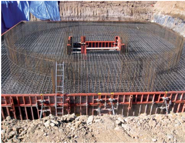
Figura 9.- Vista general de la losa de cimentación de la torre de control del aeropuerto de Barcelona.
