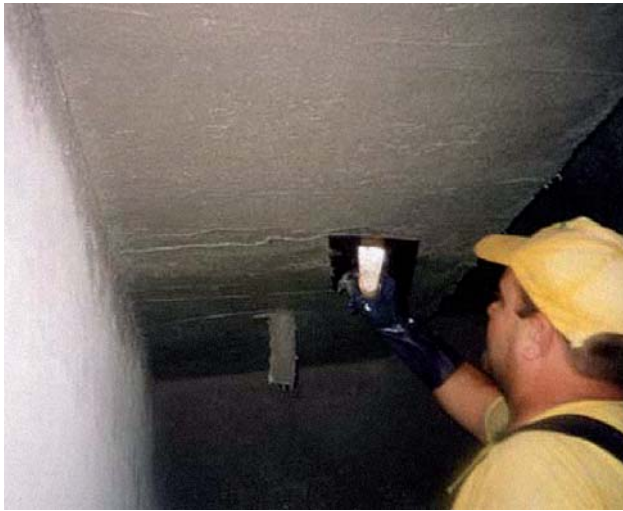
⇒ Figura 14.- Aplicación del mortero de reparación.
