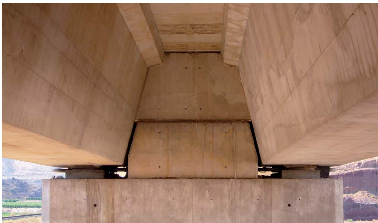
Figura 7.- Tope transversal en apoyos.
