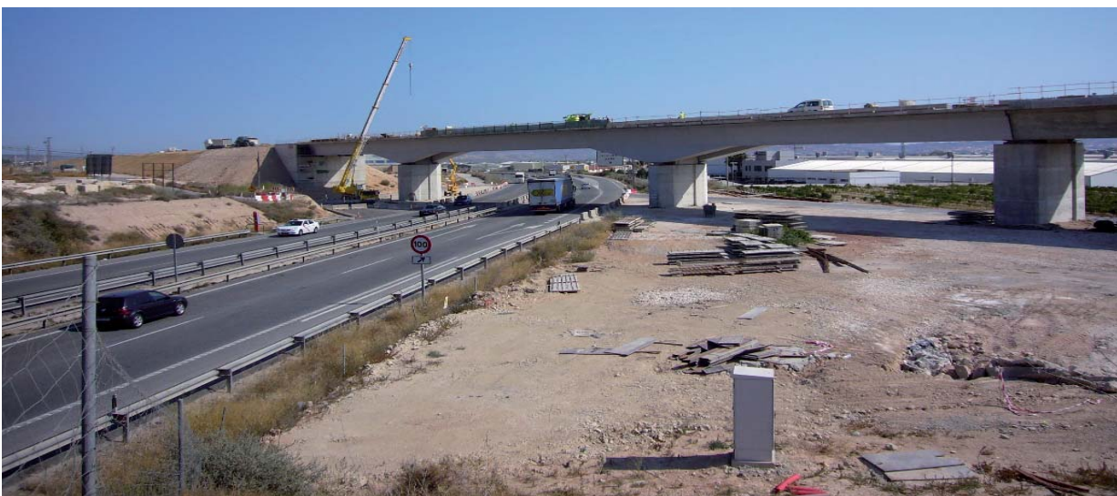
Figura 1.- Vista general del Viaducto de Baladres a su paso sobre la N-330.
