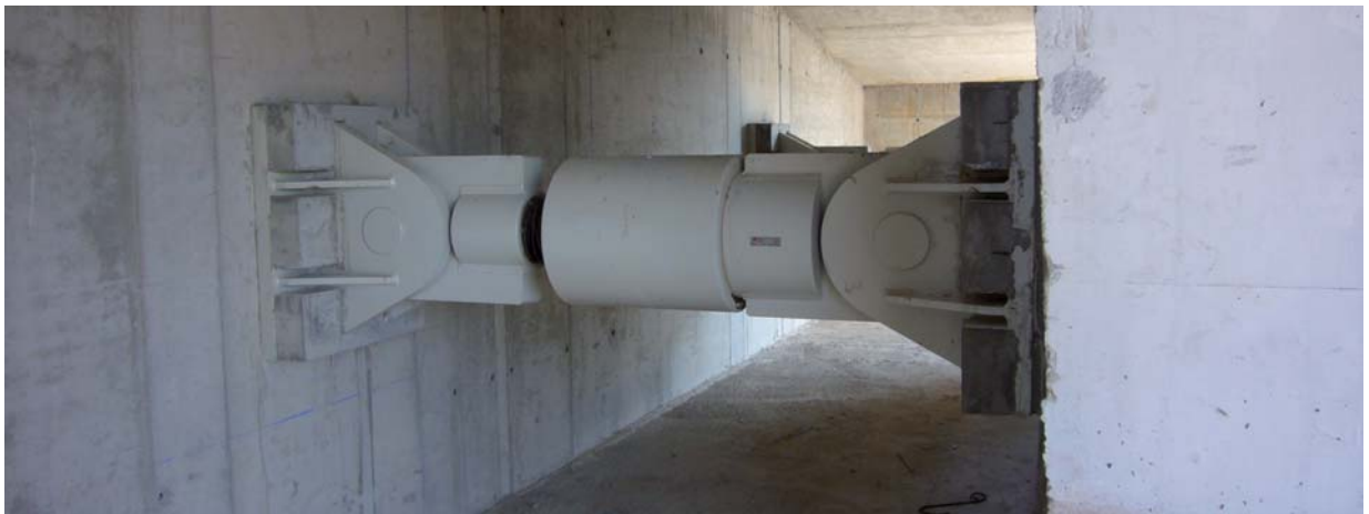
⇒ Figura 6.- Disposición de amortiguadores en estribo.
