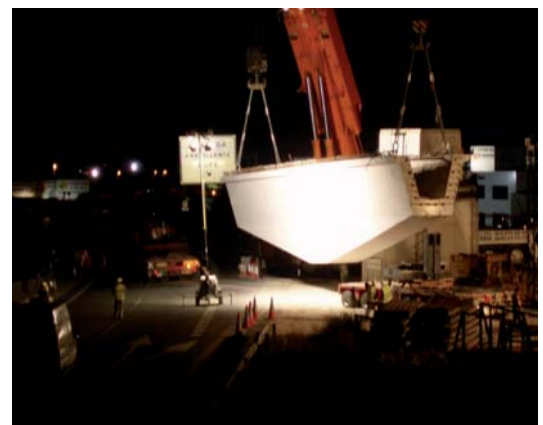
Figura 9.- Proceso constructivo del puente. Fase 1.
