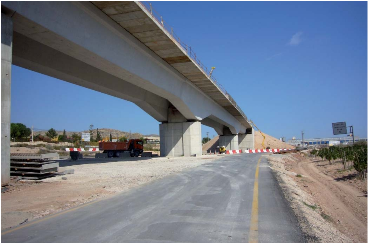
⇒ Figura 11.- Proceso constructivo del puente. Puente a falta de acabados.
