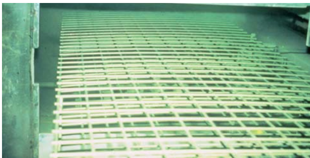
Figura 3.- Aplicación de revestimiento epoxi sobre una malla electrosoldada.
