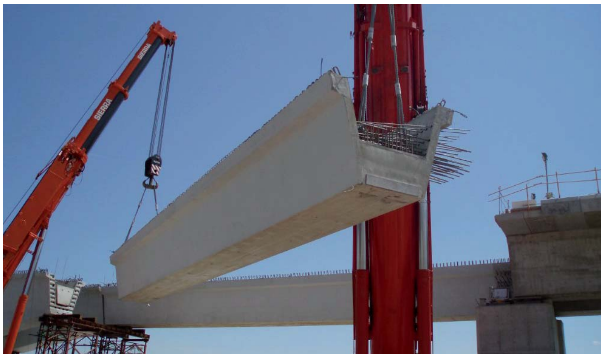
Figura 10.- Proceso constructivo del puente. Fase 2.
